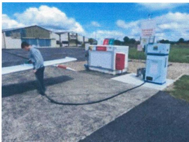
Le tuyau se déroule en émettant des séries de cliquetis. Le deuxième cliquetis indique que le tuyau est « bloqué » et qu'il ne se ré-enroulera pas;
